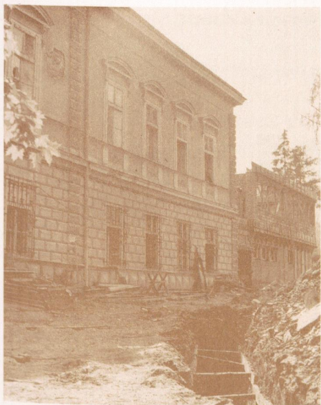
Stavebné úpravy, rok 1983
